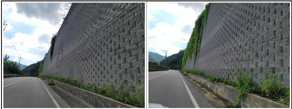
【사진 4.3.1】 지반, 기초부 전경
