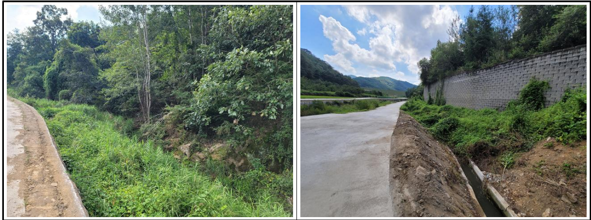
【사진 4.3.6】 지반, 기초부 전경
