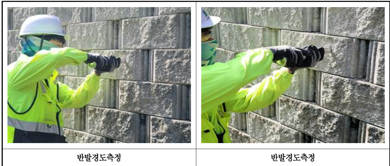
【사진 4.4.1】 재료시험 조사 전경
