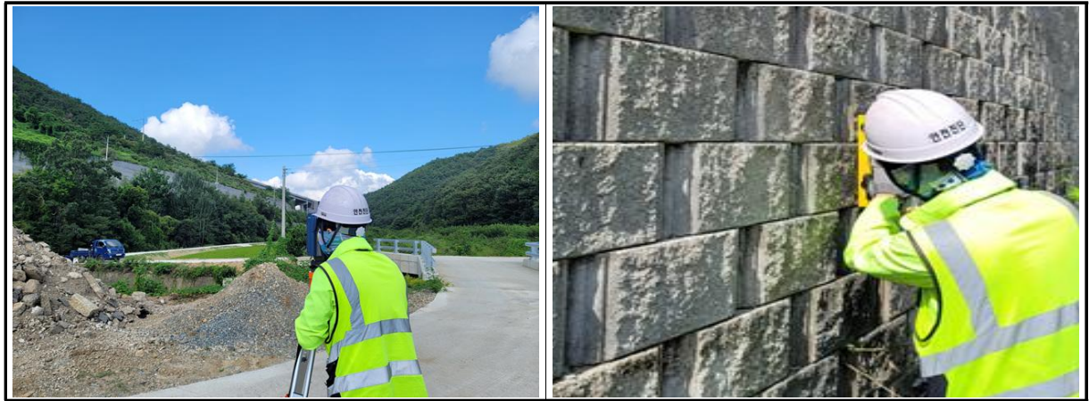
【사진 4.4.2】 측량작업 전경
